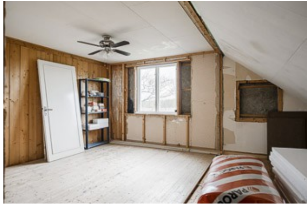
DG angefangene Renovierung
