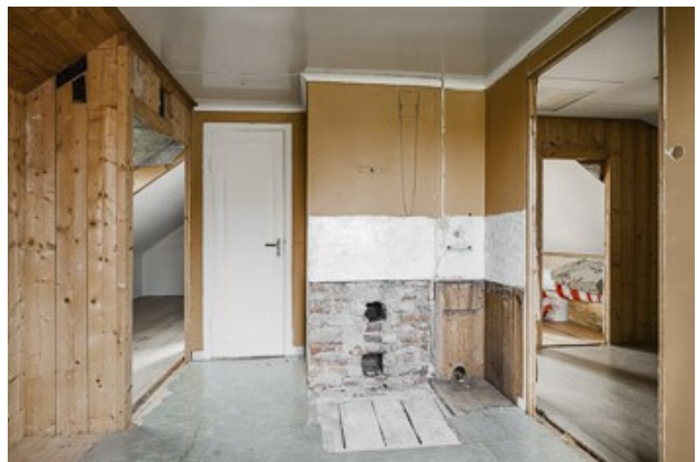
DG angefangene Renovierung
