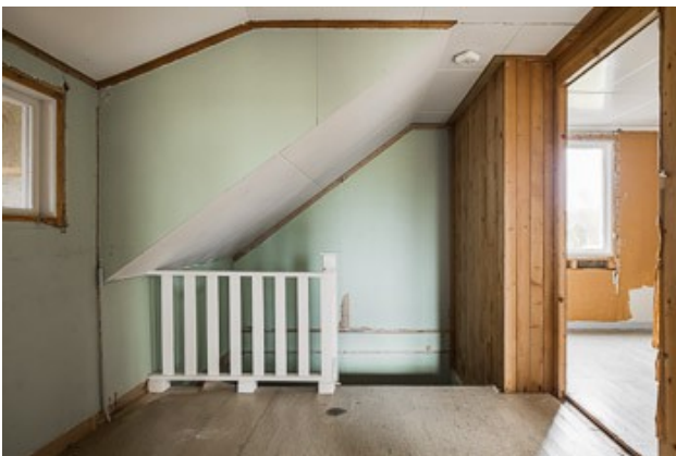
DG angefangene Renovierung
