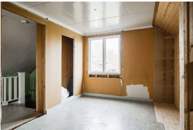
DG angefangene Renovierung
